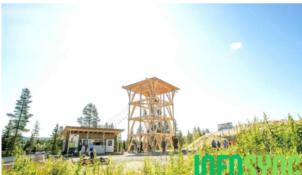
Hoyt lavt klatrepark trysil alle
