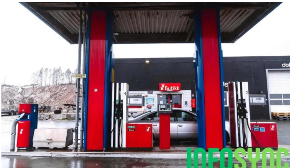
Yx froya bensinstasjon
