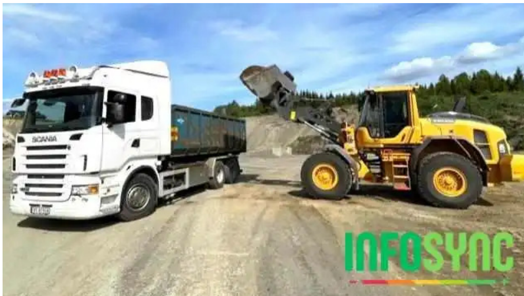
Meraker betong as fra eieren
