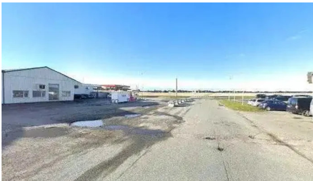
Statens vegvesen brekstad trafikkstasjon alle
