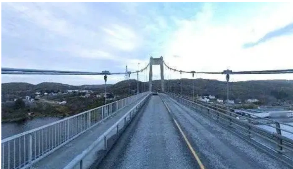
Naerøysundbrua street view 360deg
