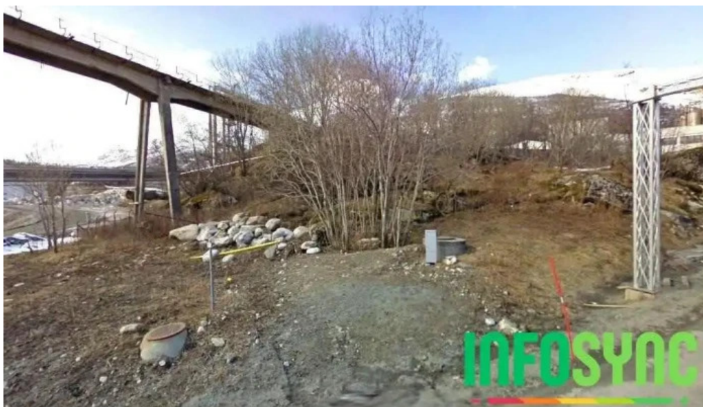
Glomfjord tunnel glomfjord
