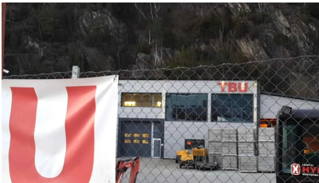
Telemark byggutleie tbu lift stillas og byggeplass notodden
