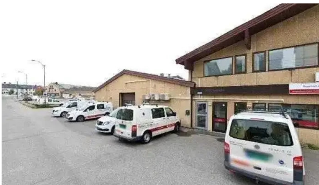
Vadso installasjon as alle
