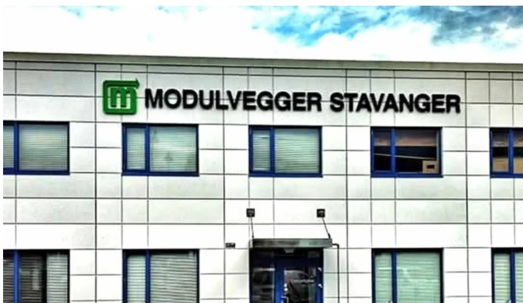
Modulvegger stavanger entreprenør
