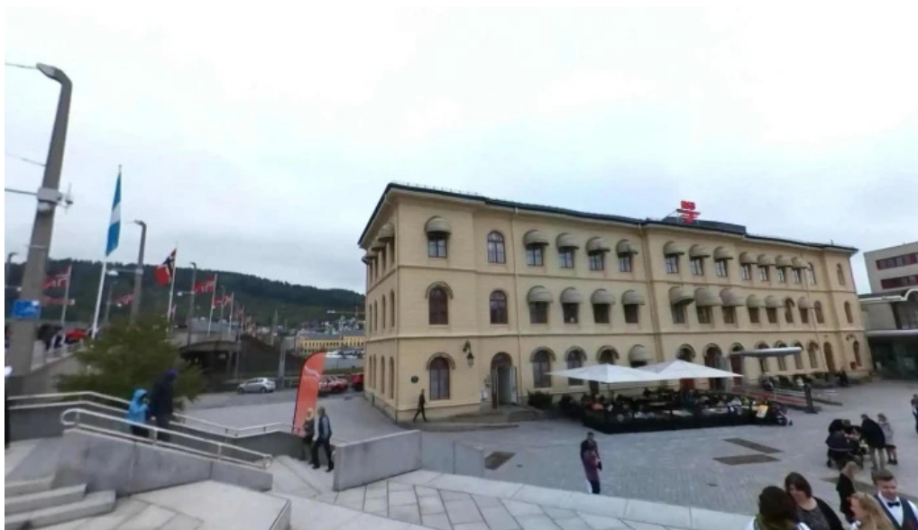
Drammen stasjon street view 360deg
