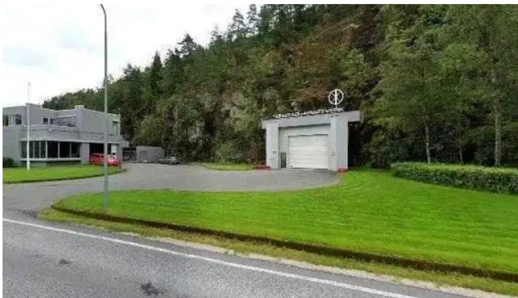
Tonstad kraftverk street view 360deg
