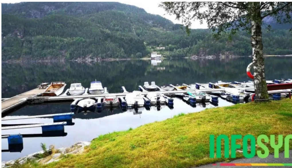
Tonstad kraftverk tonstad
