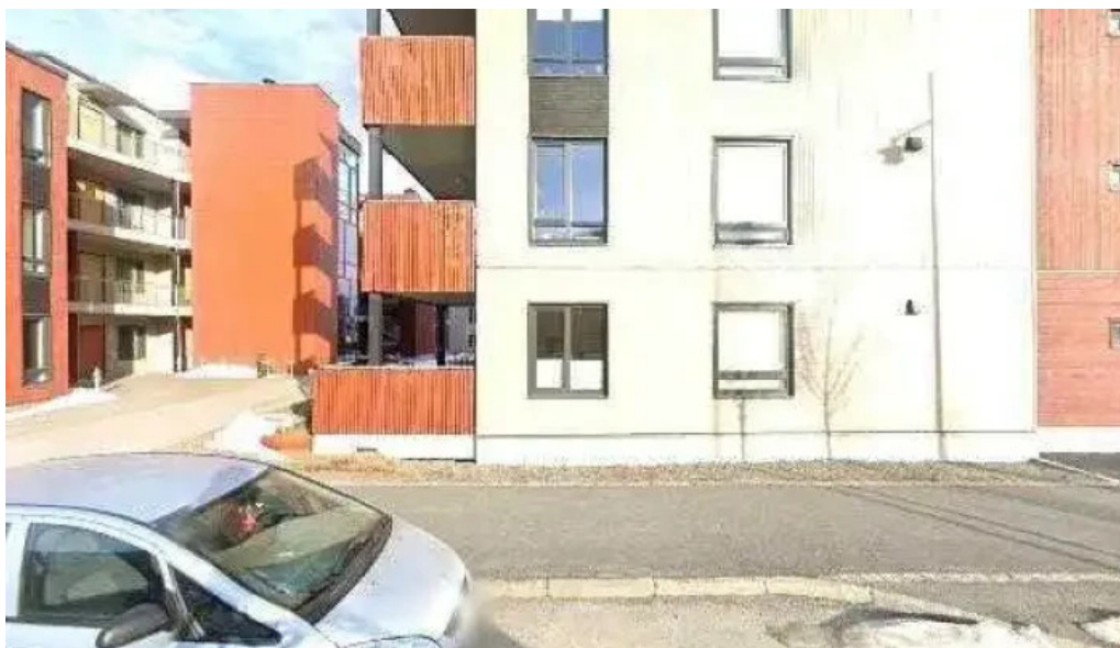
Byggern hommelvik street view 360deg
