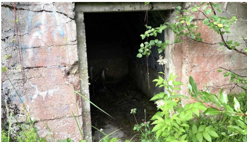
Batterie loding alle
