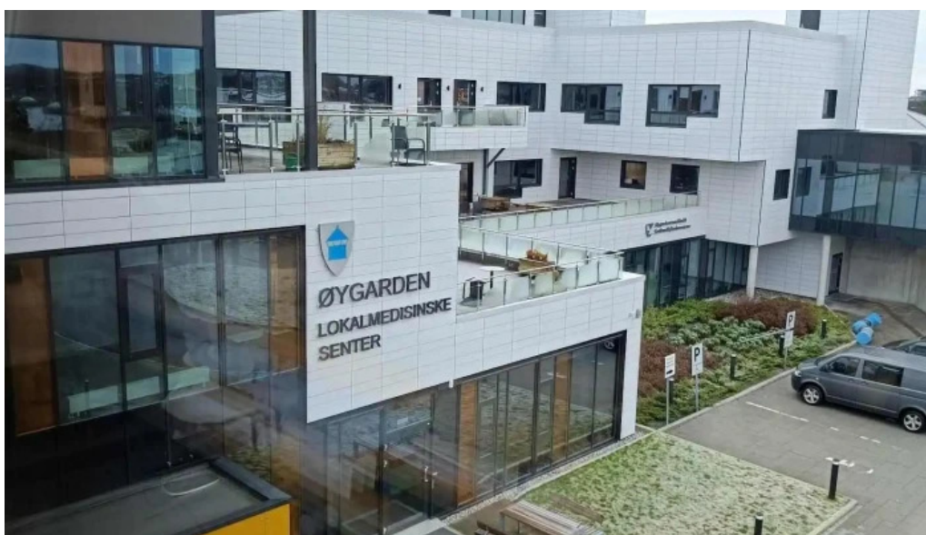
Øygarden lokalmedisinske senter alle
