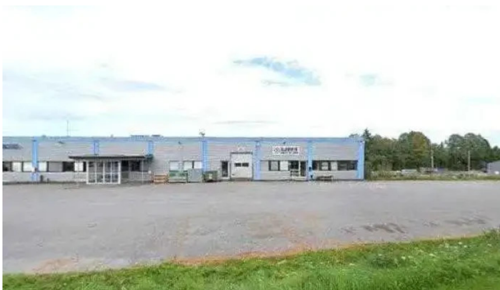
Gjovik varme og sanitaer as alle
