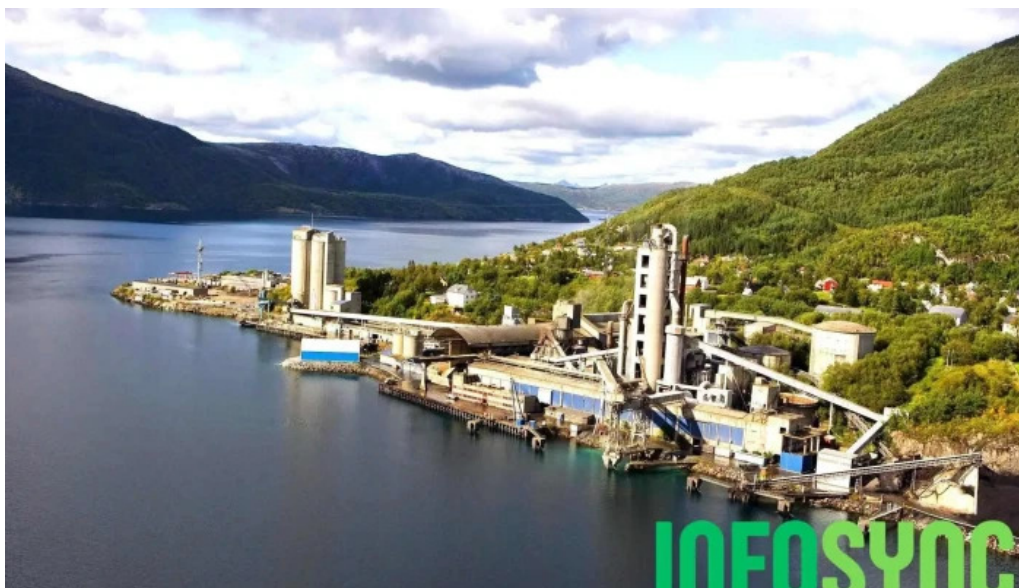
Heidelberg materials kjøpsvik sementfabrikk fra eieren
