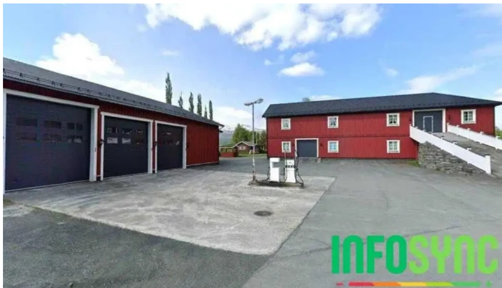
Meråker toll og kontrollhall meråker
