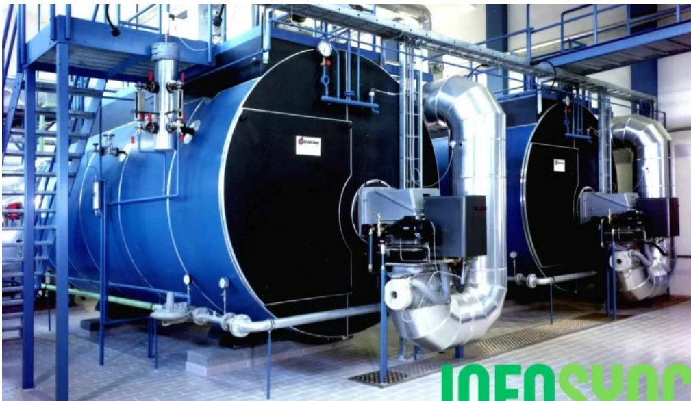
Skaland ror industrimontasje as alle
