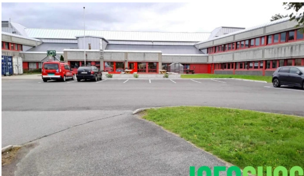
Sandsli videregående skole alle
