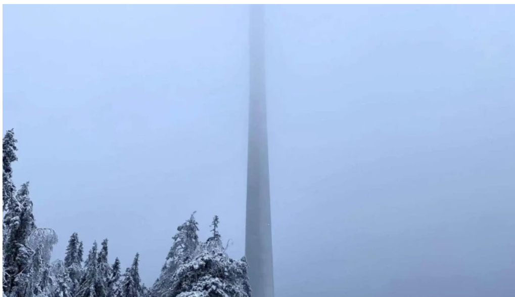
Odal vindkraftverk vindmøllepark
